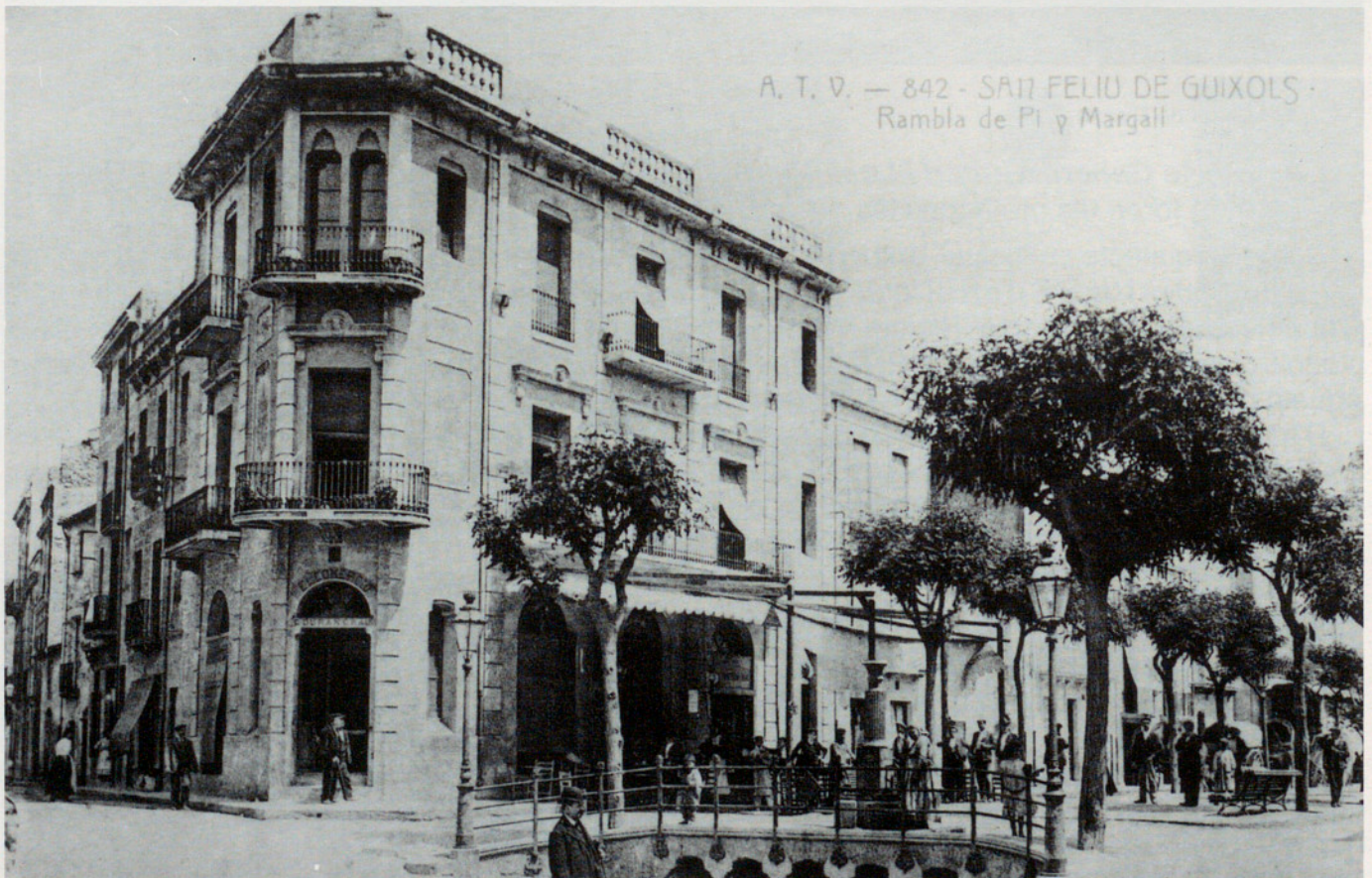
3.3 Reforma que comportà un clavagueram central i cinc boques d'entrada, al Portalet. Obra de G. Guitart.
