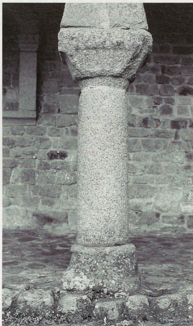
Figura 3: Columna del pis inferior en la que s'observa l'arrodoniment que presenten els elements a causa de la pèrdua de volum superficial, així com la colonització de la pedra per part de líquens.
