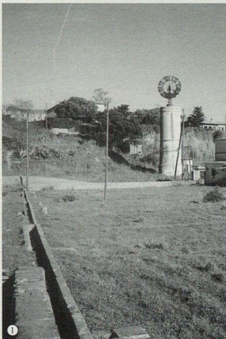
1. Canalització per on circulava l'aigua des del safareig gran cap a les feixes. Foto: Pere Sala
