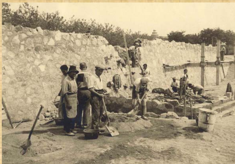
Construcció del mur de protecció de la platja, a principis dels 40 (AMSFG, Col. Municipal d'Imatges. Autor: Joan Sabater)
