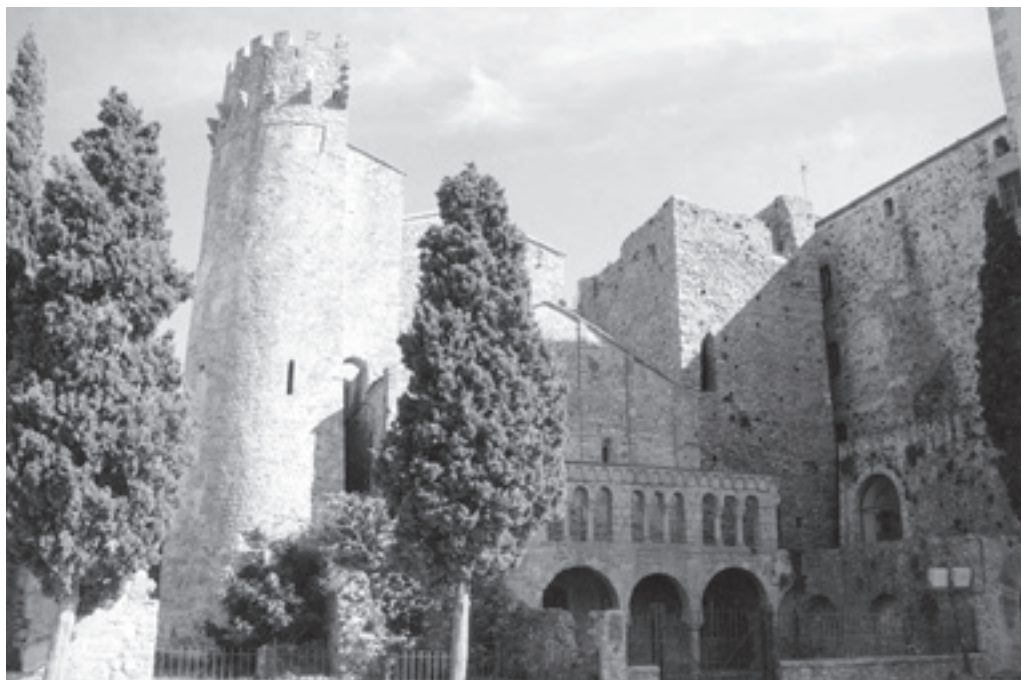
Vista del Monestir abans de la restauració de la Porta Ferrada. Fons del MHSFG (Foto Berganti).
