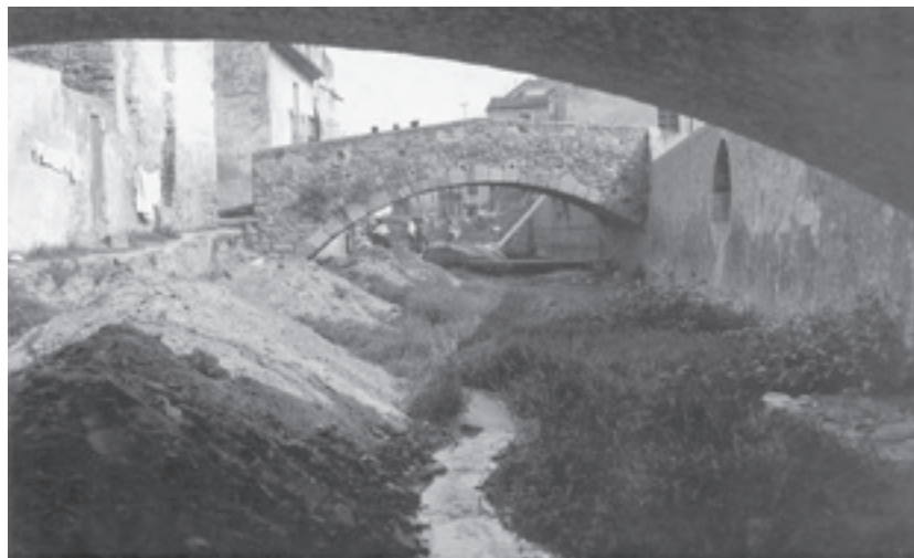
Cobriments de la riera del Monestir (1934). La fotografia va ser realitzada des de sota mateix del pont del carrer de l'Hospital.
