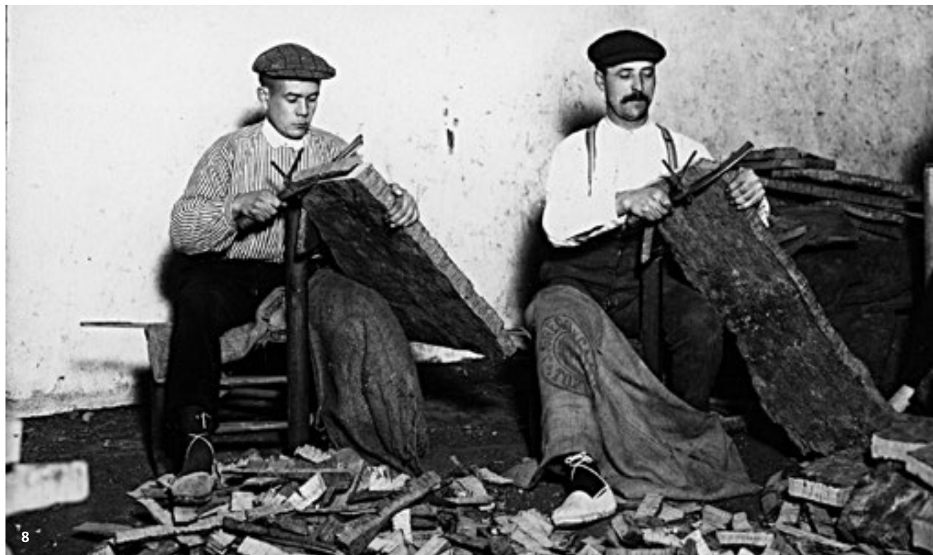
8. Procés de fabricació de taps de suro, treballadors llescant el suro a mà, l'any 1925. AMSFG. Fons Ricard Mur Dargallo. (Autor: Ricard Mur Dargallo) 9. Procés de fabricació de taps de suro, màquina de garlopa, 1925. AMSFG. Fons Ricard Mur Dargallo (Autor: Ricard Mur Dargallo)
