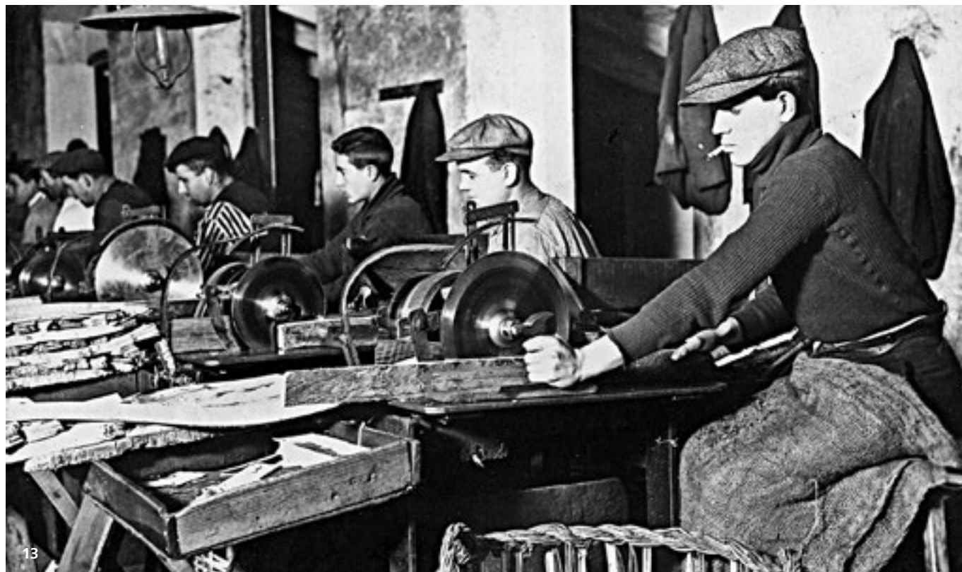
13. Llescant suro a màquina per a la fabricació de discos de suro natural per fer taps, 1925. AMSFG. Fons Ricard Mur Dargallo. (Autor: Ricard Mur Dargallo) 14. Premsat de motlles durant el procés de fabricació d'aglomerats de suro i col·locació en vagonetes, l'any 1925. AMSFG. Fons Ricard Mur Dargallo. (Autor: Ricard Mur Dargallo)
