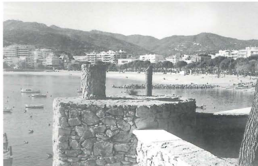
Vestigis del que va ser la bateria de dos canons instal·lada des de 1751 a la punta dels Guixols.
