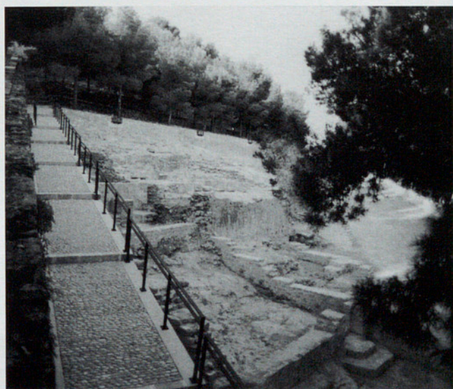
Fig. 5. Castell de Dénia. Rehabilitació dels vestigis arqueològics de la Vila Medieval.
