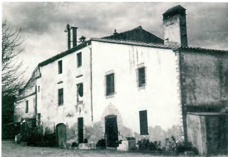
Fig 125. Granja de les Eroles i ermita del Remei, abans de la parròquia i terme de Sant Feliu i ara de Castell d'Aro; fotografia del 1968. L'ermita és al centre de l'edificació; la llinda de la porta d'entrada duu, gravada, la data 1732 i, al seu damunt, hi ha un escut de pedra, del monestir guixolenc, que n'era el propietari. En efecte, en temps de l'abat Bernat (1163-89), Pere Saguer, de la Vall d'Aro, donà la granja al monestir. El 1641 les edificacions varen ser refetes quasi de nou. A conseqüència de la desamortització, el 1822 la finca fou subhastada; tenia 164 vessanes i l'adquirí Josep Martí i Estruch, de Barcelona, per 640.000 rals. A l'ermita els fidels hi havien portat exvots, entre els quals recordem uns vaixells penjats del sostre, que en el decurs de la guerra del 1936-39 foren dipositats al Museu Marítim de Barcelona d'on el senyor Ensesa no els pogué recuperar. Antigament s'hi celebrava un aplec anyal que era molt concorregut. A la masia, ara hi ha un restaurant. L'abat sempre sostingué que la granja era dins del seu delmari, com consta en el document del 1354. La seu gironina, en canvi, pretenia que era en el seu.
