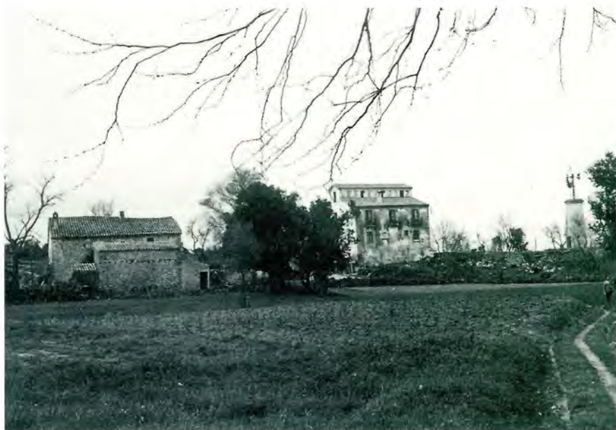
Fig 114. Barri de la Brugada segons una fotografia del 1968. Al centre, can Jofre, abans Mansea (primera meitat del segle XV) i Roquer (primera meitat del segle XVIII), ara propietat de Maria Gimbernat. A la dreta, el seu molí de vent per a pouar aigua; a l'esquerra, can Ganiguer, que avui són quatre cases: can Gandol, can Llambí, can Geli i can Duran.
