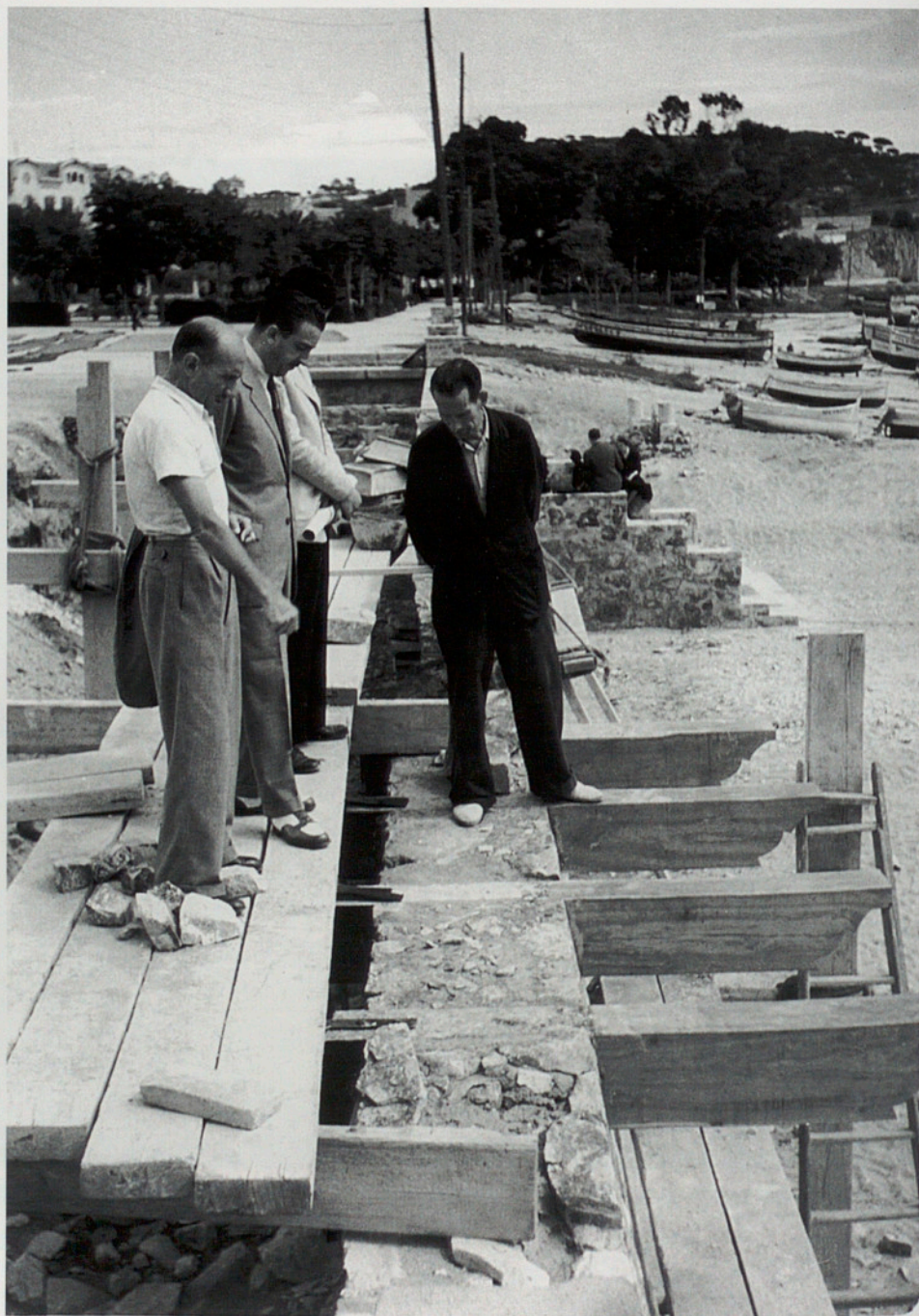
4 - L'alcalde Gandol i l'arquitecte Avelino Amadevilla revisen els treballs de construcció del mur de protecció de la façana marítima (1943-1944). Autor: Pere Rigau. AMSFG.
