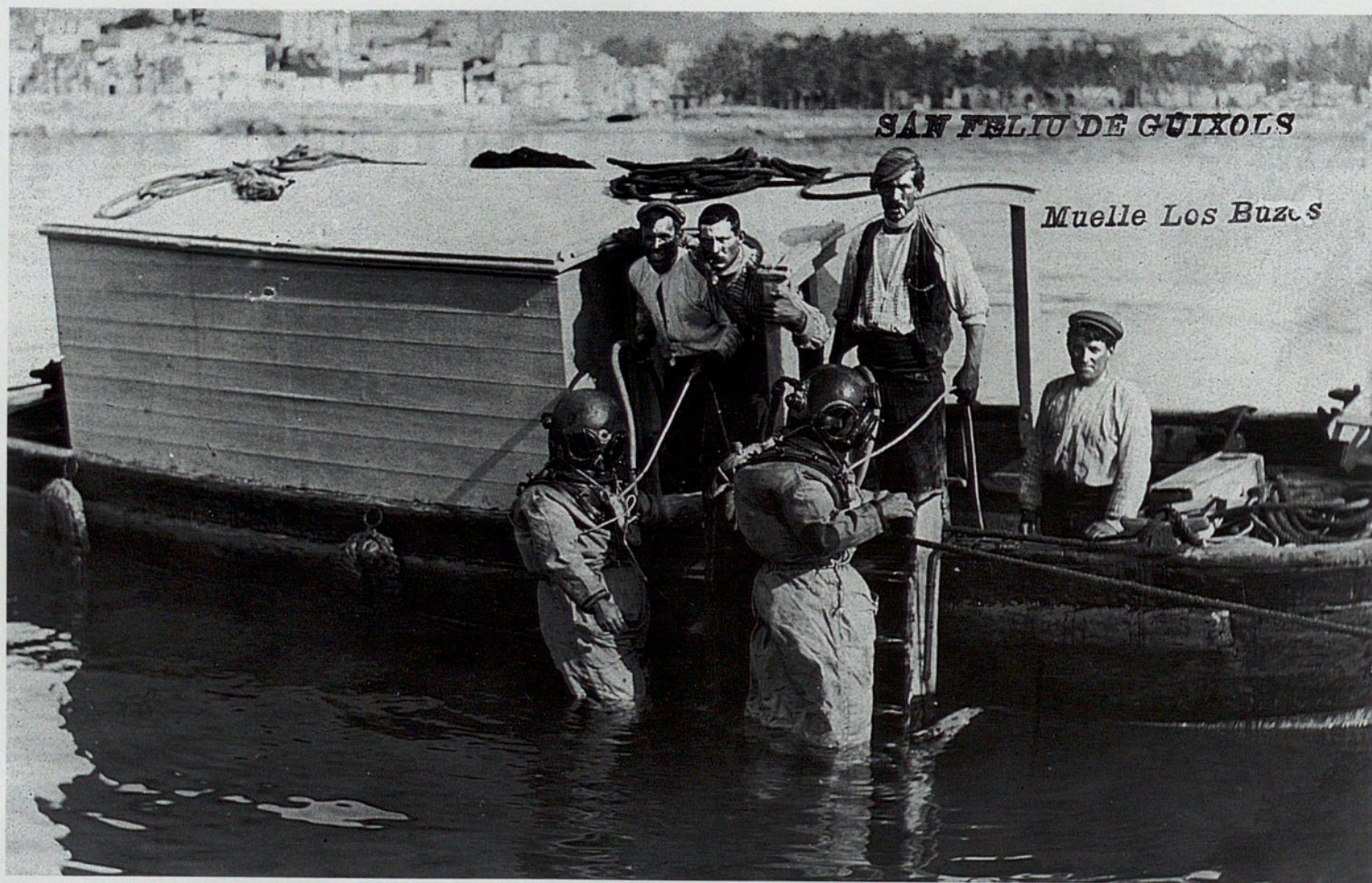
3 - Dos bussos submergint-se dins les aigües de la badia en el transcurs de les obres de construcció del port, pels volts de 1906-1907. Autor: el desconec. Col. autor.
