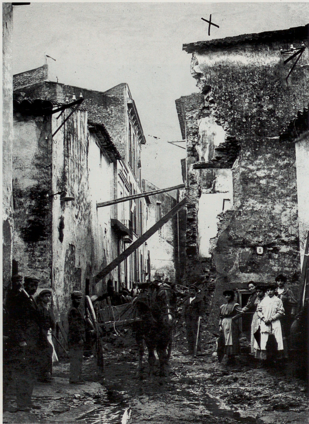
3 - Una creu assenyala la casa enderrocada per la força de la riuada al carrer Monestir, raó per la qual va perdre la vida un infant de 9 anys. Autor: el desconec. AMSFG.
