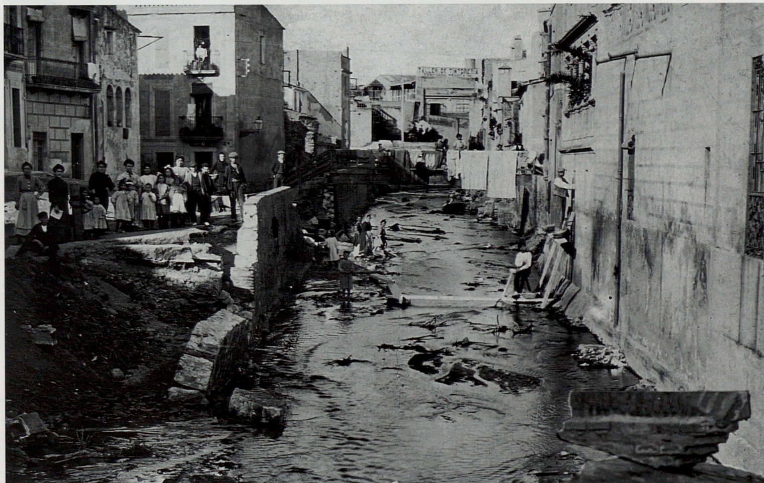
2 - Detall de les destrosses ocasionades en el mur de canalització de la riera. Autor: el desconec. AMSFG.
