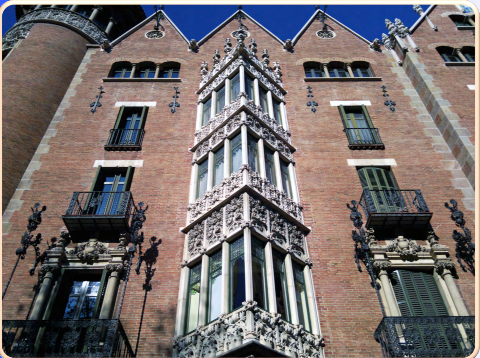
Façana de la casa de les Punxes de Josep Puig i Cadafalch. Barcelona.
