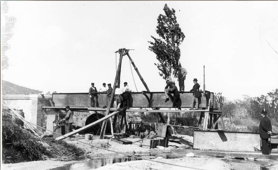
Construcció del pont sobre el Ridaura, 1889-1892
