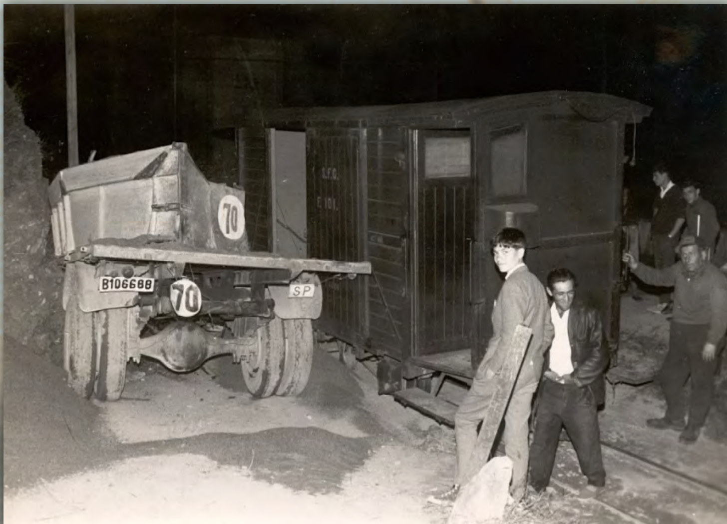
Brigades actuant al pas a nivell de la Creueta a causa d'un accident amb un camió, als anys 60
