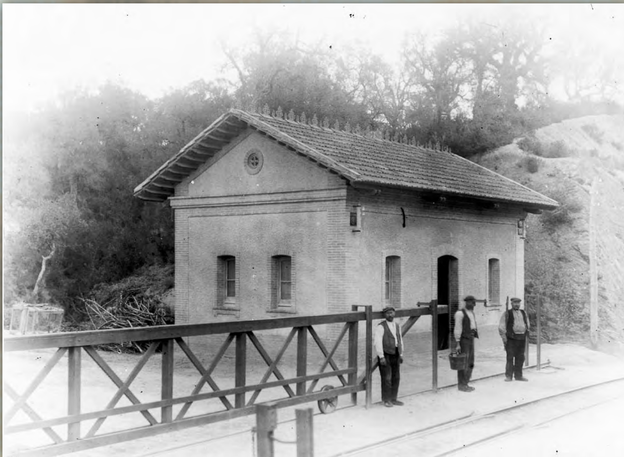
Caseta de la guardessa del pas a nivell de Penedes
