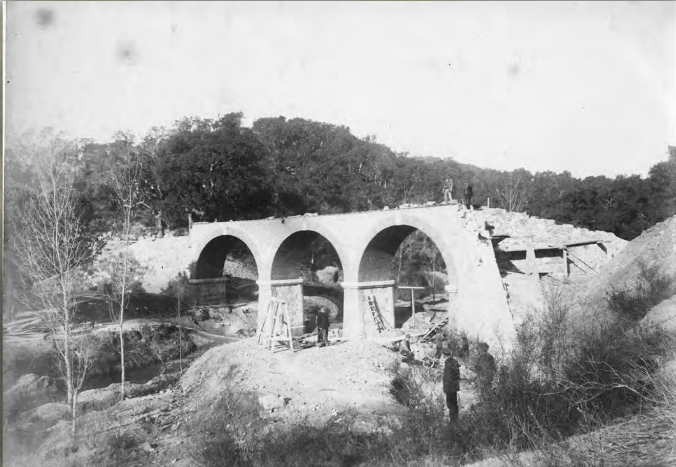
Construcció del pont de Salenys, 1890 AMSFG. Col·lecció Espuña-Ibáñez (Autoria desconeguda)
