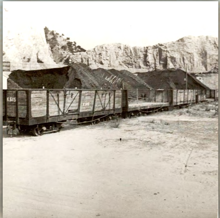
Vagons de plataforma i de vora alta al port
