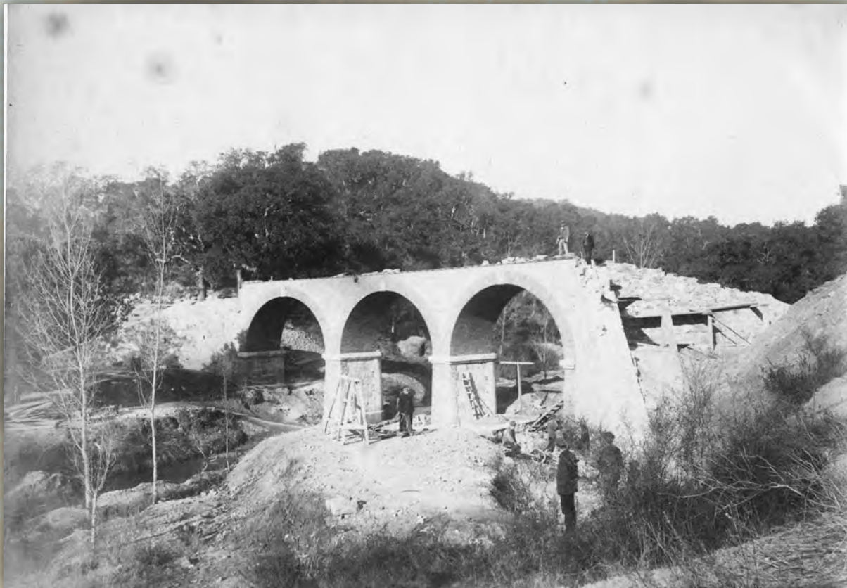
Construcció del pont de Salenys, 1890
